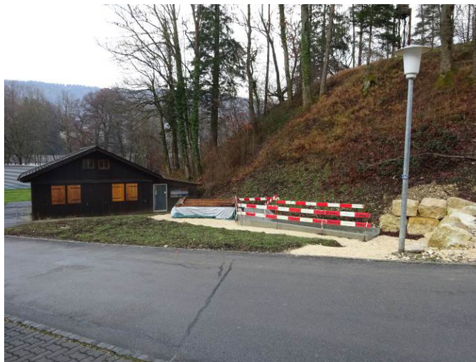
Centrale de turbinage enterrée (situation avant le montage de la toiture démontable et de la couverture sur l'accès)
