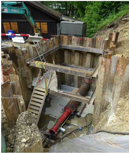
Fonçage pneumatique de la conduite de fuite (dans une enceinte de palplanches)
