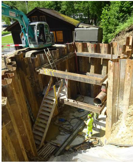
Fonçage pneumatique de la conduite de fuite (dans une enceinte de palplanches)
