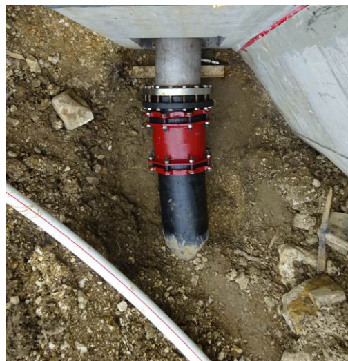
Manchon mécanique (Waga)
