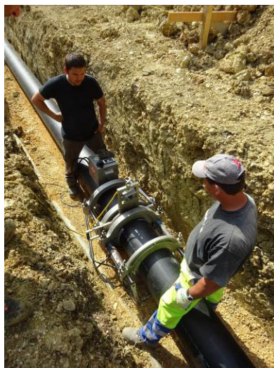
Soudure bout à bout
