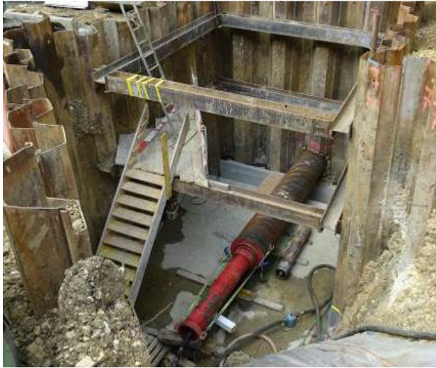
Entlastungsleitung mit Rammvorstoss
