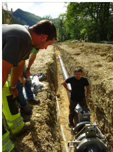
Zusammenschweißen der Rohre
