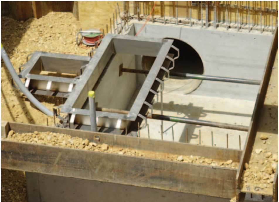
Abb. 12: Grube unterhalb der Turbine (Einlass), die zur Entlastungsleitung führt
