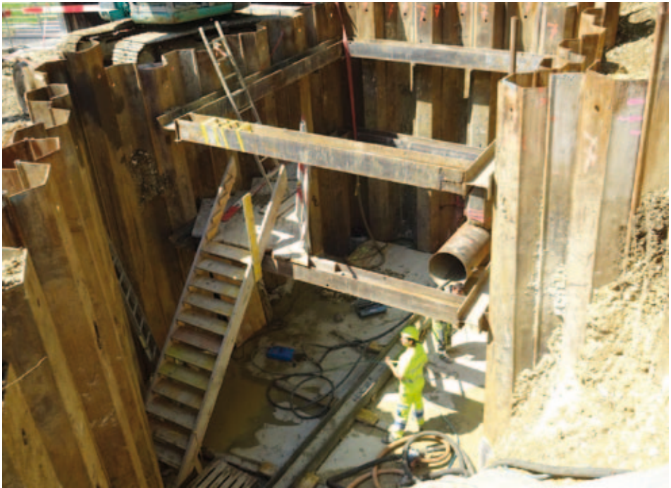
Abb. 7: Baugrube (Spundwand mit Stützeinheiten)
