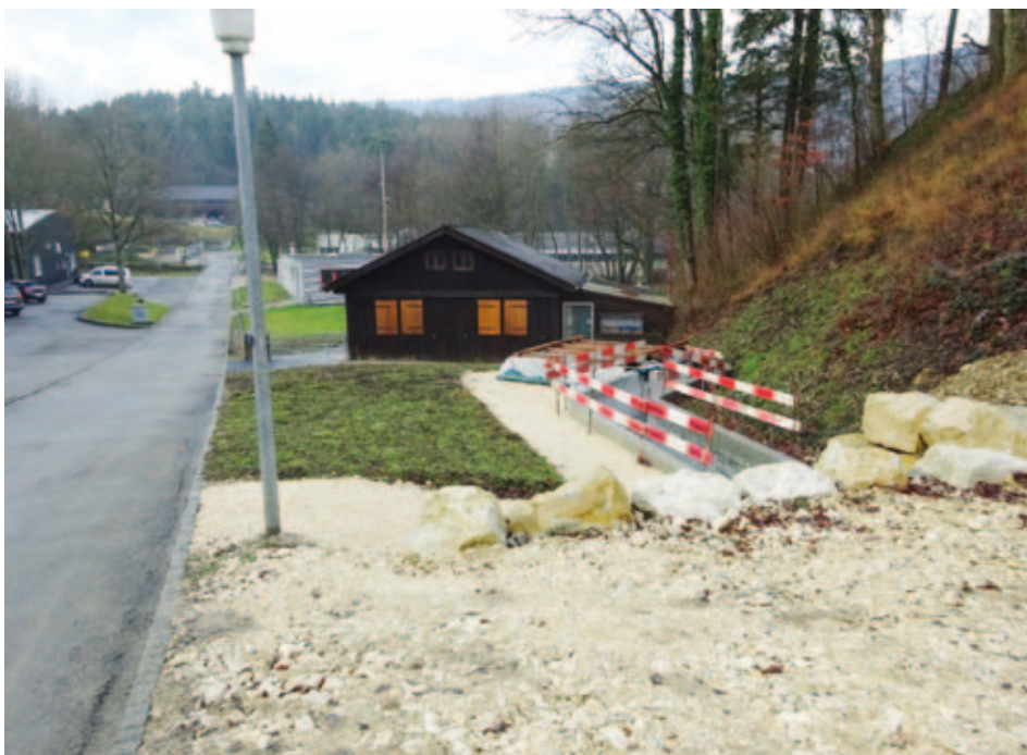
Abb. 13: Unterirdische Turbinenzentrale (Stand vor der Montage des Daches über der Maschinen- gruppe und dem Gebäudezugang)
