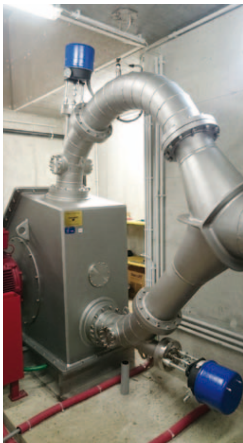
Abb. 10: Hosenrohr mit zwei motorisierten Düsen
