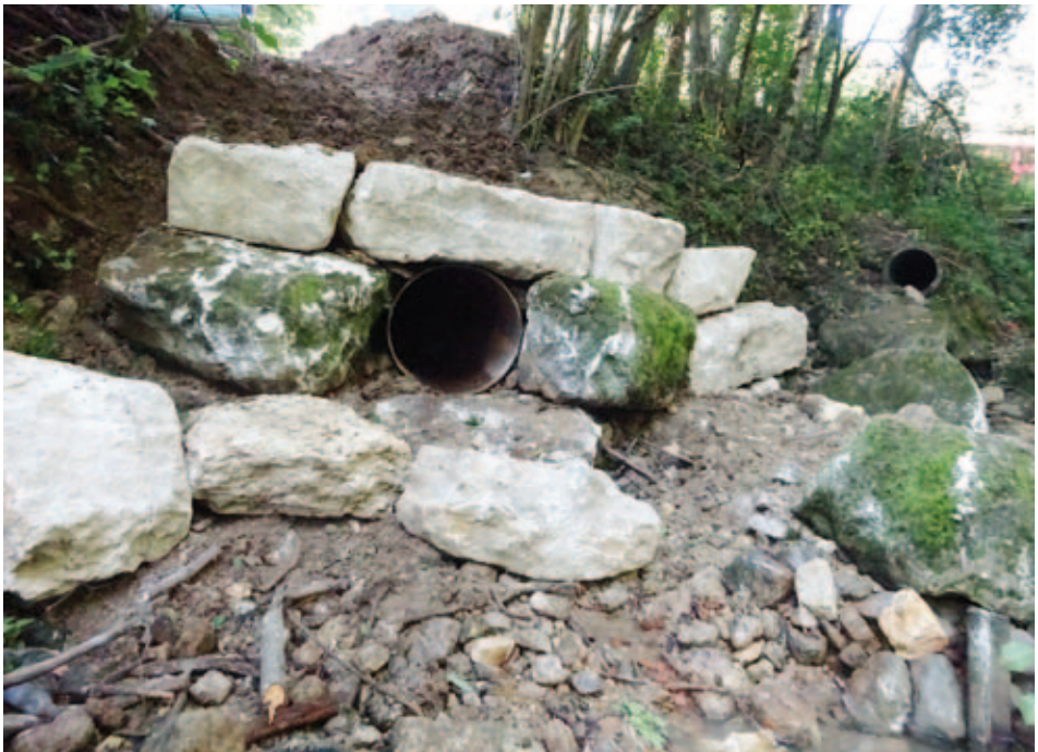
Abb. 8: Die Entlastung in der Böschung der Birs (Stahlrohr mit Felsblöcken verkleidet)
