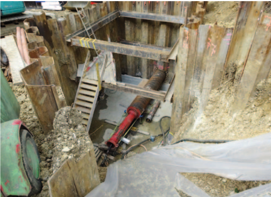
Abb. 6: Entlastungsleitung mit Rammvorstoß (pneumatisch)
