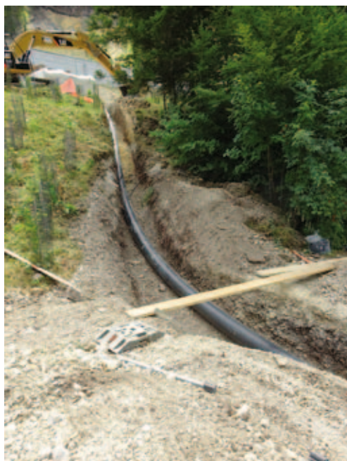
Abb. 14: Sanfte Kurven der Druckleitung mit leicht gekrümmten Rohrelementen
