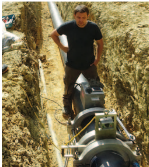
Abb. 15: Zusammenschweißen der Rohre im Graben der Rohrleitungen
