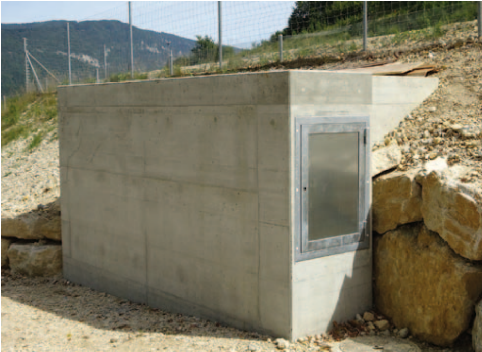
Abb. 5: Der unterirdisch und im bestehenden Hang ausgebaute Wasserspeicher
